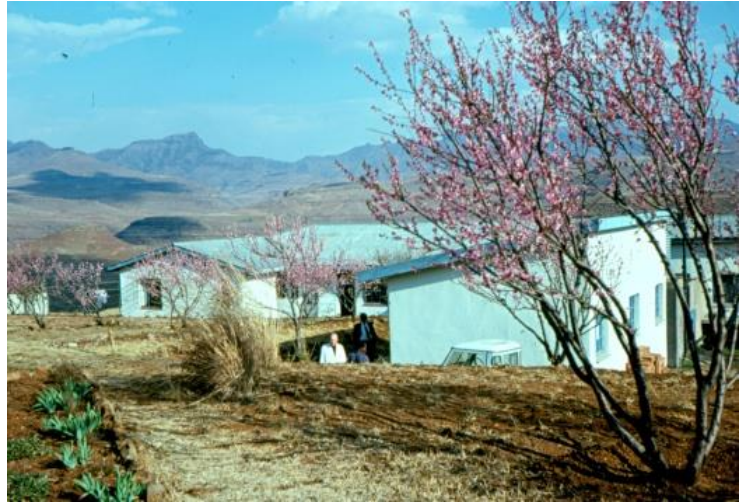
Hôpital de Tebellong (Lesotho)
