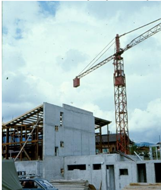
Construction du futur Centre réformé
