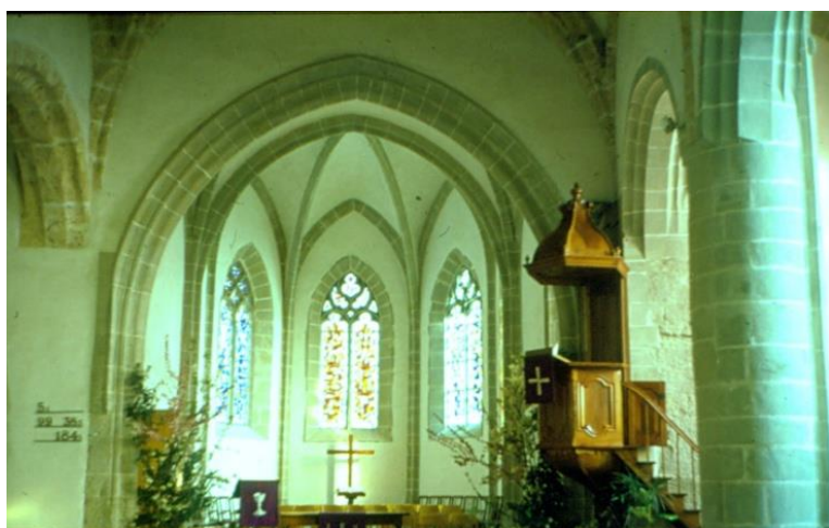
Eglise paroissiale St Vincent: le chœur
