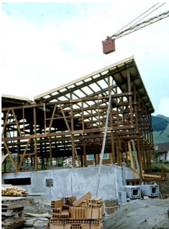
Construction en bois sur rez en béton
